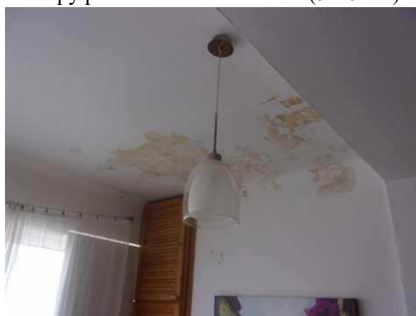
Stopy po zatékání v bytě v 6.NP
