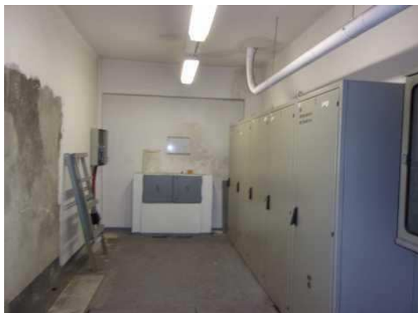
Stopy po vztlínání vlhkosti v rozvodně NN v 1.PP
