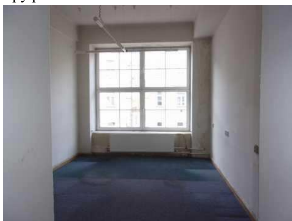
Stopy po zatékání v kanceláři ve 4.NP
