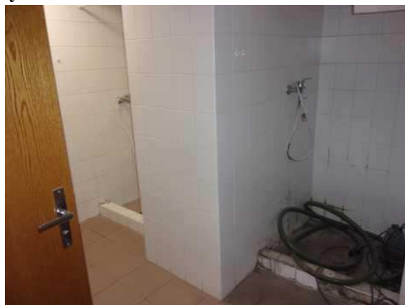
Narušené obklady a dlažba ve sprše v 1.PP
