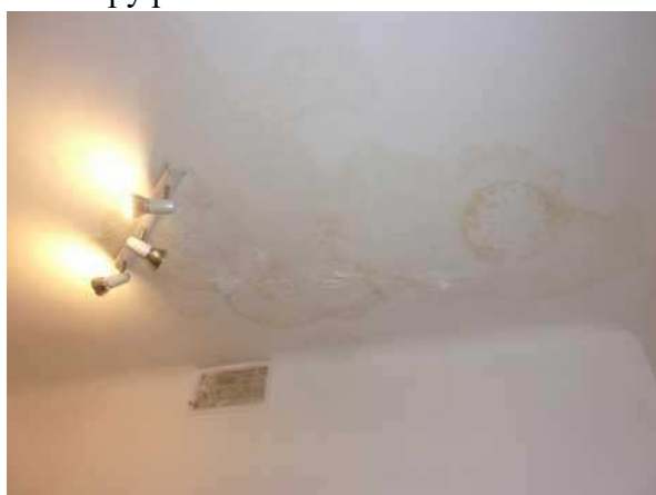
Stopy po zatékání v bytě v 6.NP
