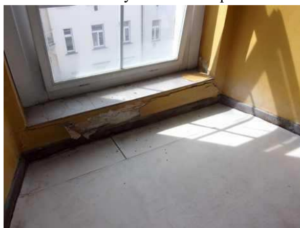
Stopy po zatékání na schodišti (5.- 6.NP)
