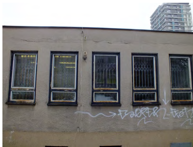
Obr.: Původní ocelová okna
