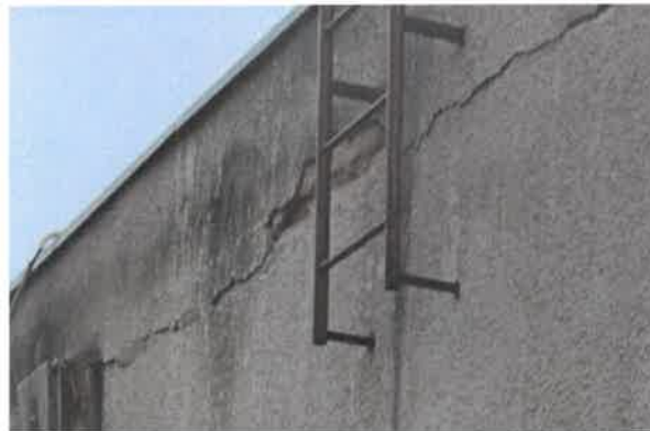
TRHLINY NA FASÁDĚ U ATIKY (RŮZNÉ PNUTÍ MATERIÁLŮ - BĚŽNÁ ZÁVADA U OBDOBNÝCH OBJEKTŮ)
