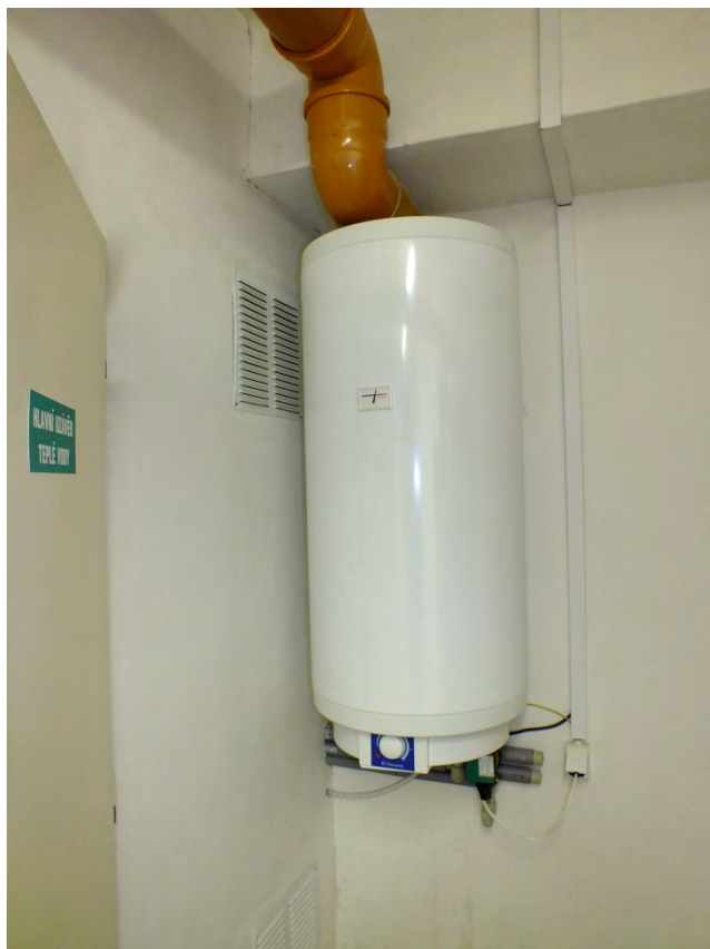
Obr.: Elektrický zásobníkový ohřivač TV
