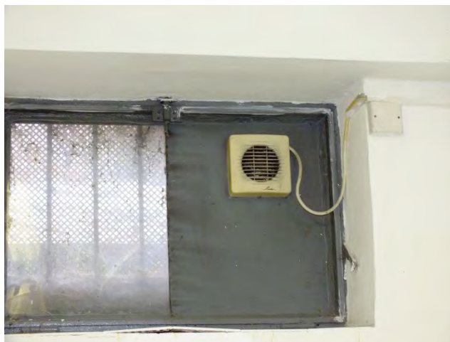
Obr.: Odtahové ventilátory (pánské šatny)
