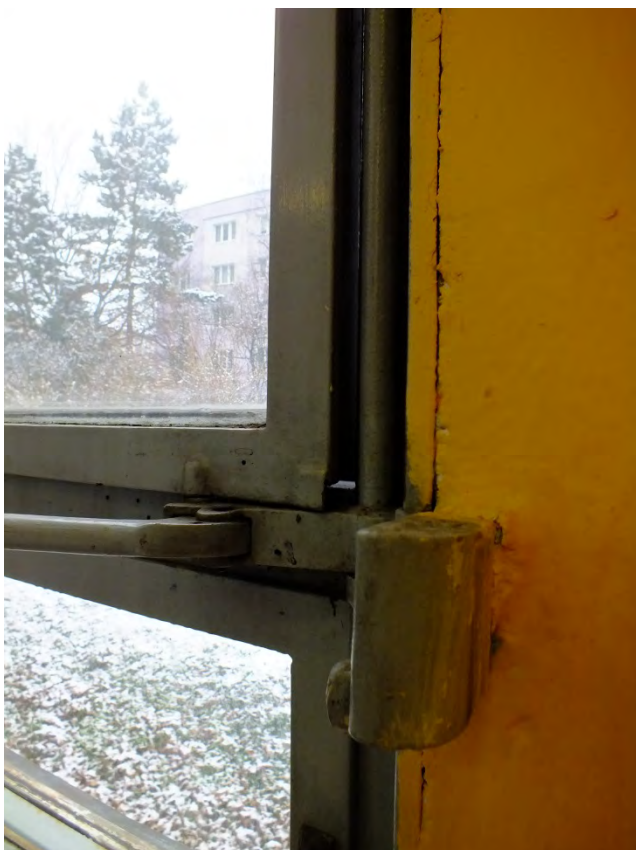
Obr.: Detail netěsnícího okna
