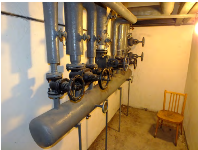
Obr: Rozdělovač/sběrač
