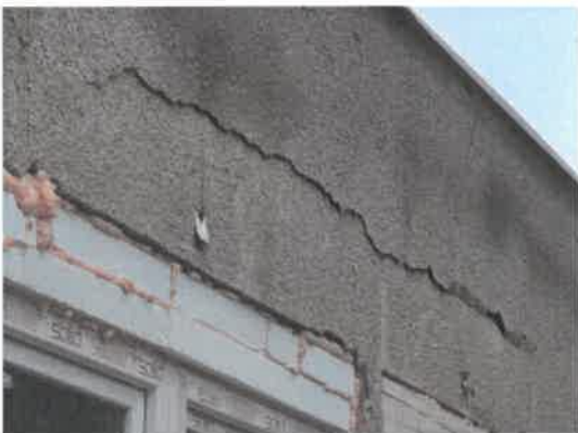
TRHLINY NA FASÁDĚ U ATIKY (RŮZNÉ PNUTÍ MATERIÁLŮ - BĚŽNÁ ZÁVADA U OBDOBNÝCH OBJEKTŮ)
