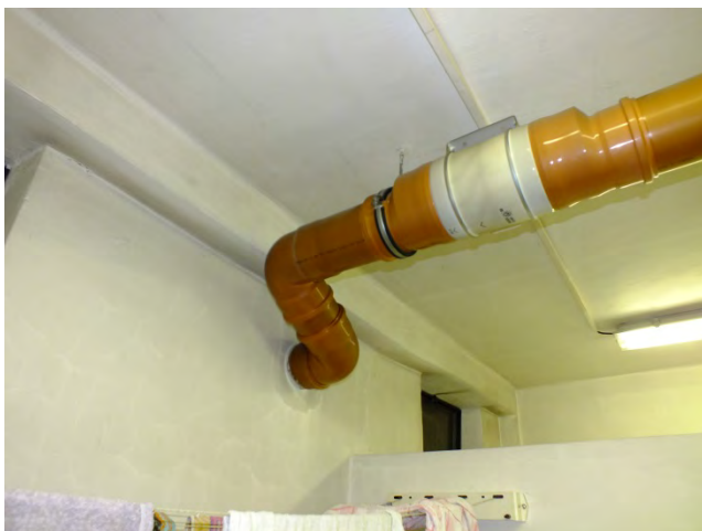
Obr.: Potrubní ventilátor (dámské šatny)
